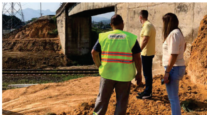
Duplicação do Viaduto na Fazenda da Barra III
