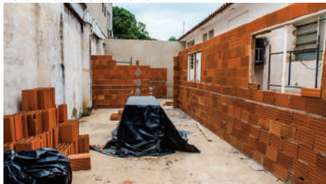
Obras do novo Espaço de Saúde Mental
