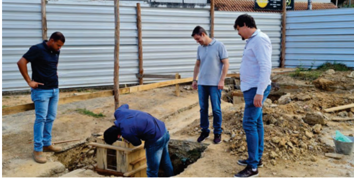
Diogo visita as obras do Centro Tecnológico no Jardim Aliança
