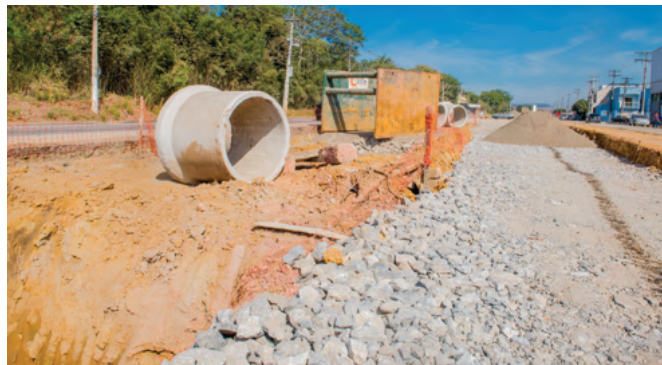
A Estrada Resende - Riachuelo, está ganhando terceira pista e obra de drenagem
