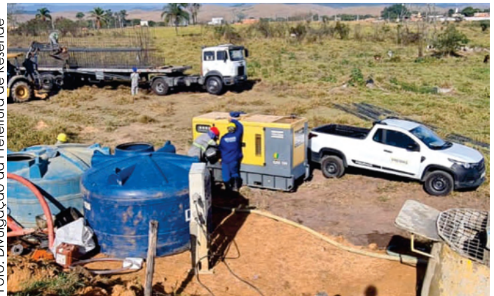
A ponte na Fazenda da Barra vai facilitar o acesso ao distrito industrial de Resende
