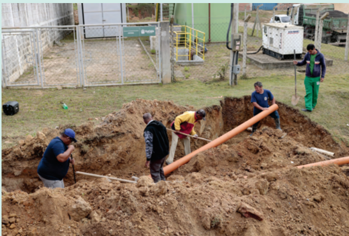
Ligação de rede de esgoto no Jardim Manchete
