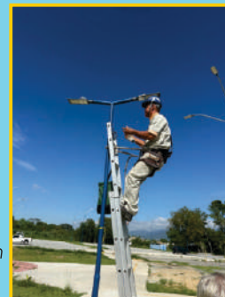
Substituição de luminária LED no ECOPARK em Resende
