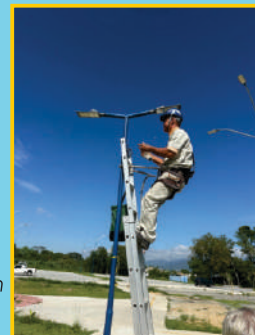
Substituição de luminária LED no ECOPARK em Resende
